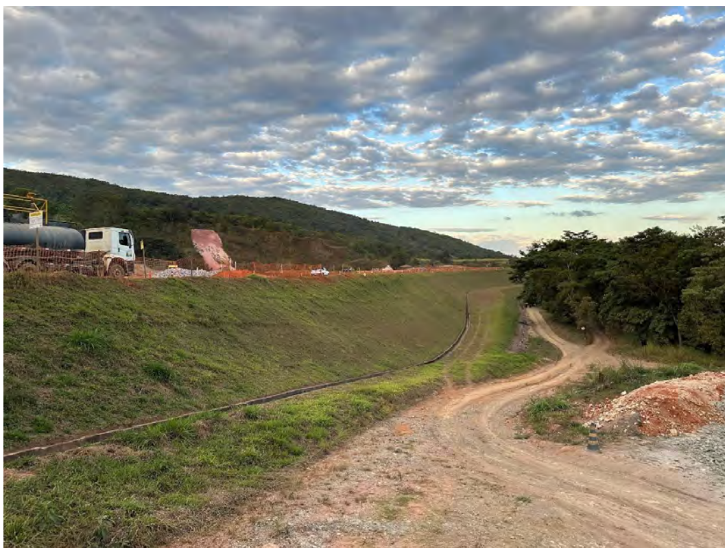
Foto 18 – Talude de jusante - Vista lateral.
