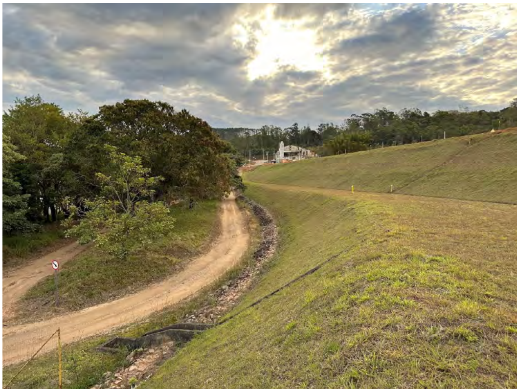
Foto 15 – Saída do dreno de fundo, próximo à ombreira direita.
