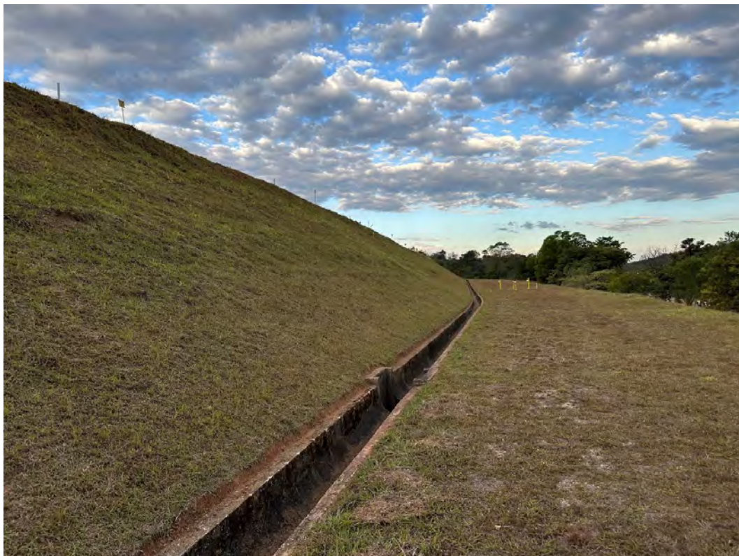
Foto 13 – Talude de jusante. Berma da cota 924 m - Vista para a ombreira esquerda.
