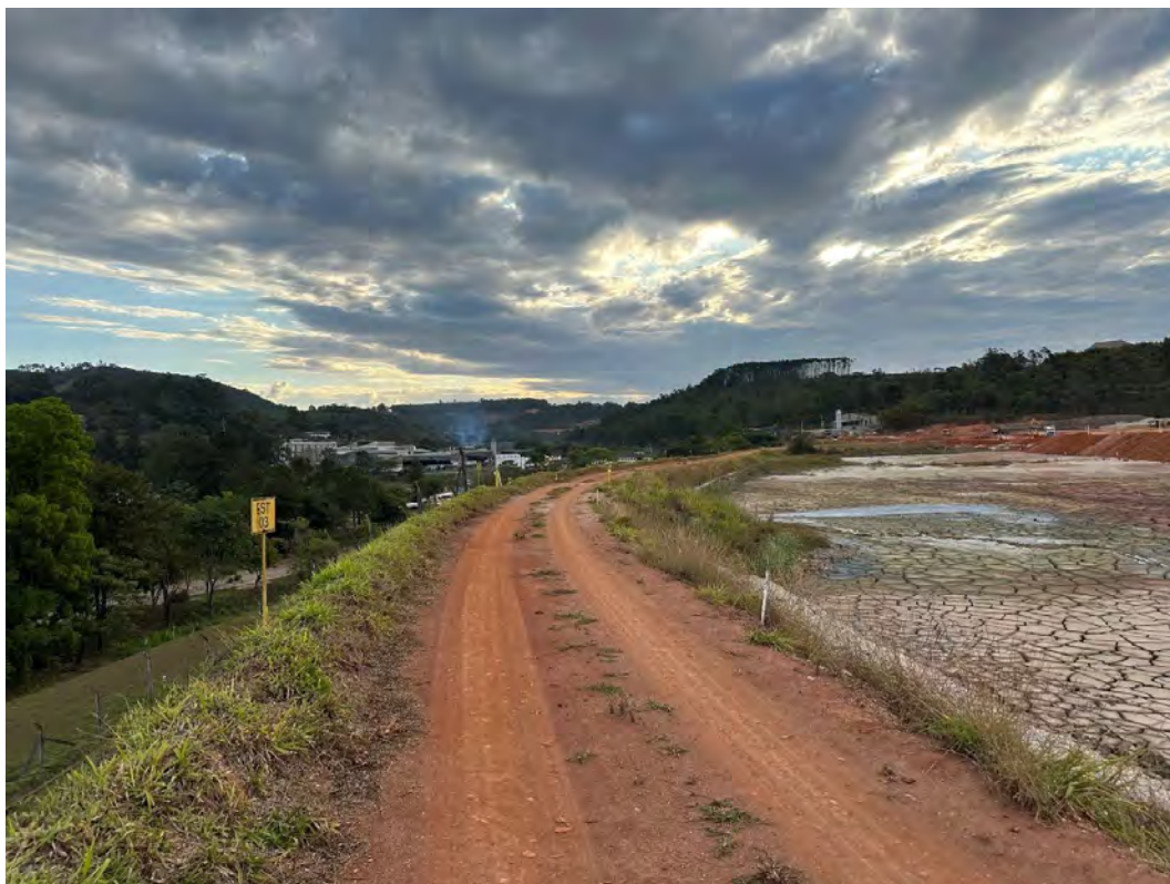
Foto 2 – Crista da barragem – Vista para a ombreira direita.
