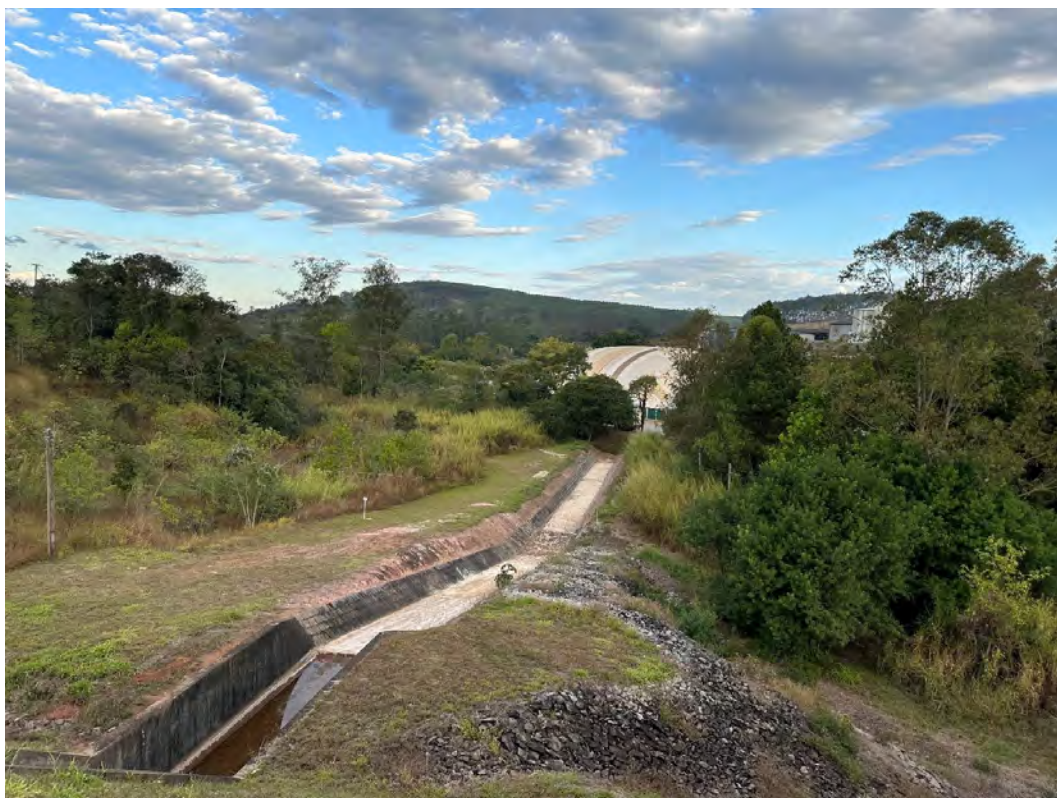
Foto 9 – Canal extravasor - escada.
