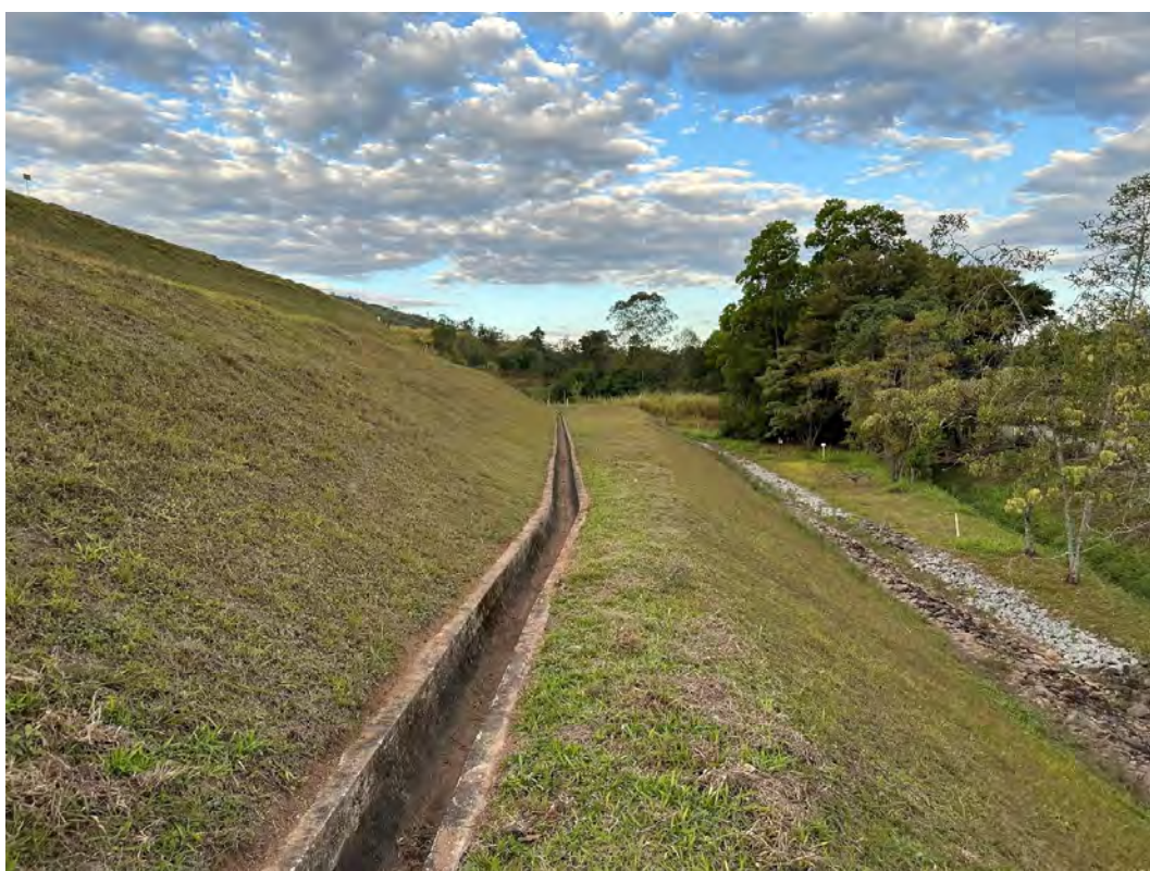
Foto 16 – Saída do dreno de fundo, próximo à ombreira esquerda.
