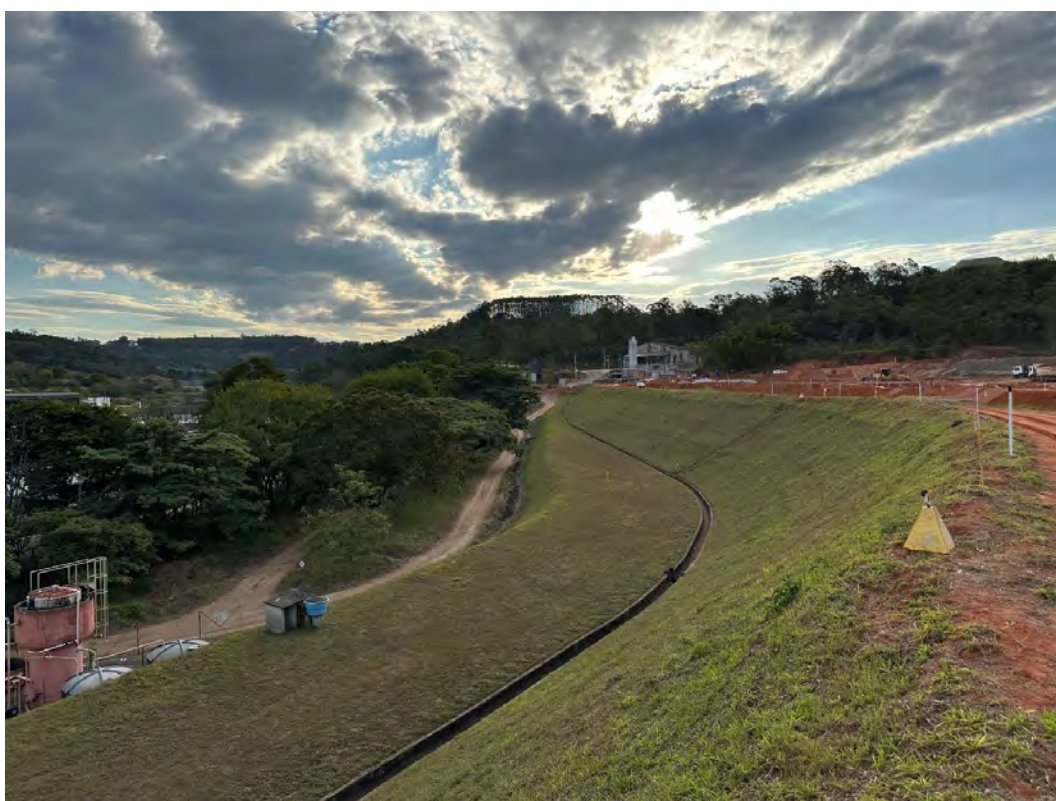
Foto 12 – Talude de jusante entre as cotas 931 e 924 m- Vista para a ombreira direita.
