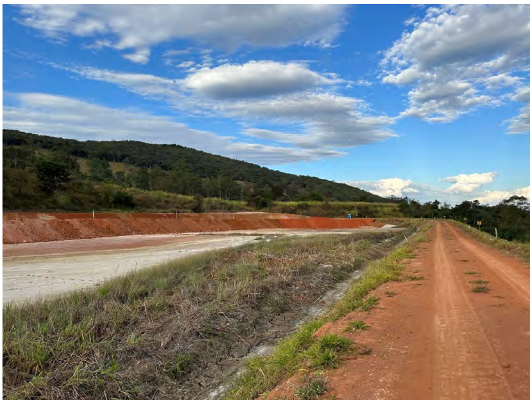
Foto 5 – Reservatório – Detalhe para o avanço do aterro de fechamento do reservatório.
