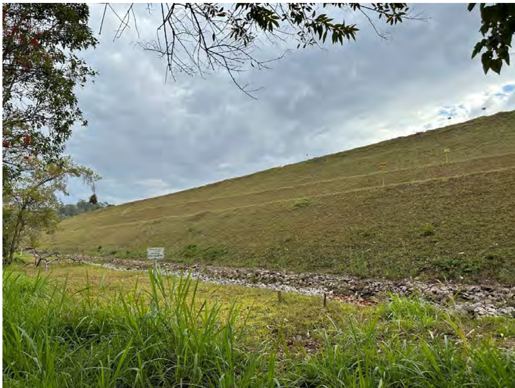
Foto 17 – Talude de jusante - Vista frontal.
