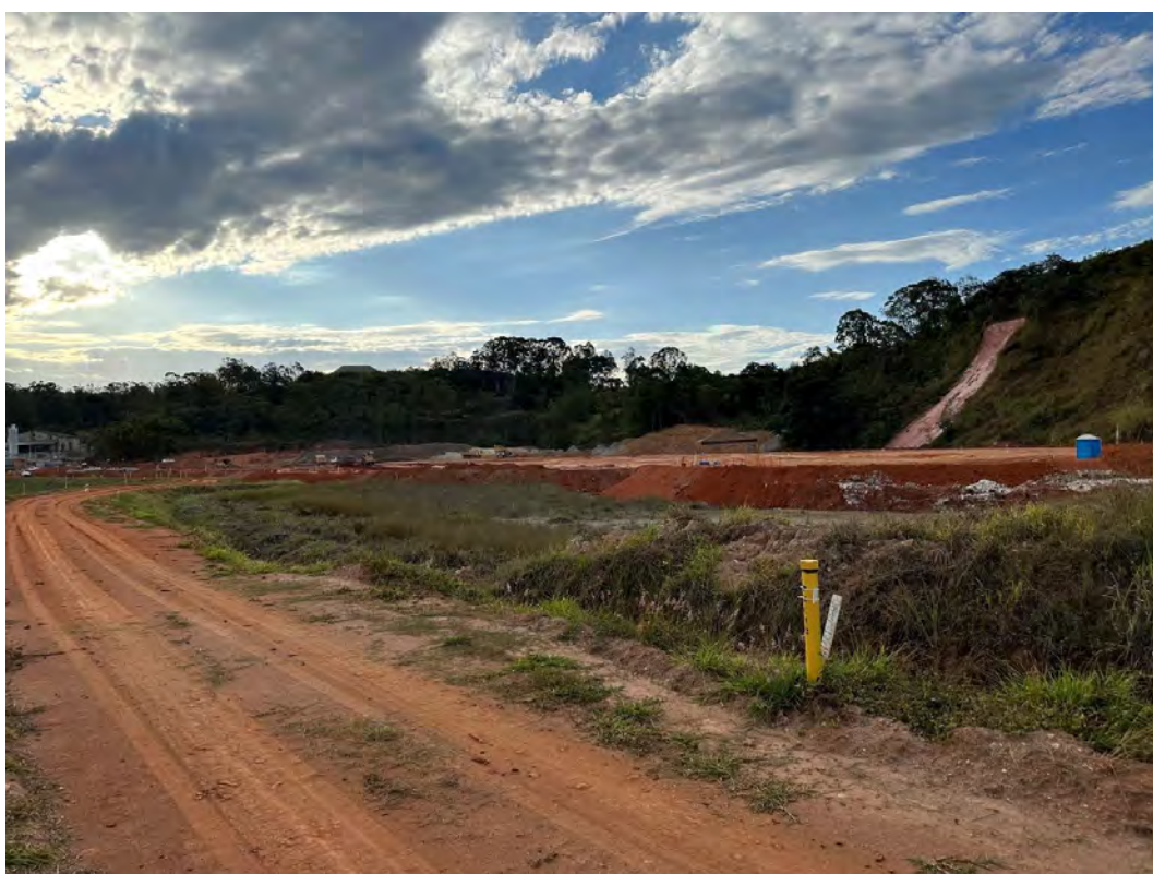
Foto 4 – Reservatório – Detalhe para o avanço do aterro de fechamento do reservatório.
