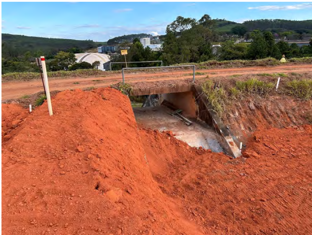
Foto 7 – Emboque extravasor – O canal de cintura irá desaguar no atual extravasor da barragem – Detalhe para as obras de aterro de encaixe do canal de cintura.
