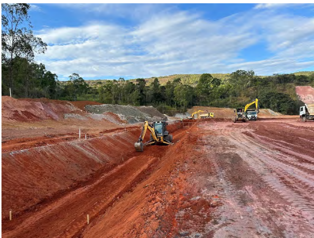
Foto 6 – Canal de cintura – Detalhe para a escavação do canal, no interior do reservatório, em alinhamento contornando a cabeceira do reservatório.
