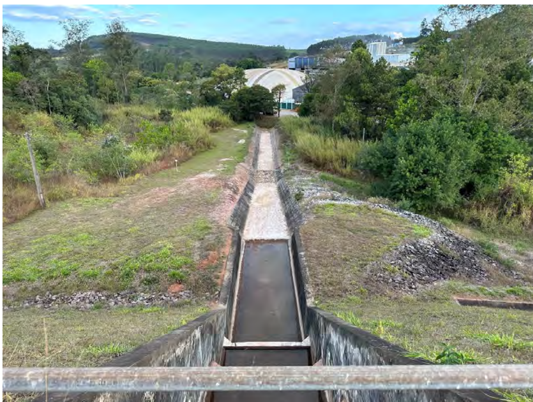
Foto 8 – Canal extravasor - escada.
