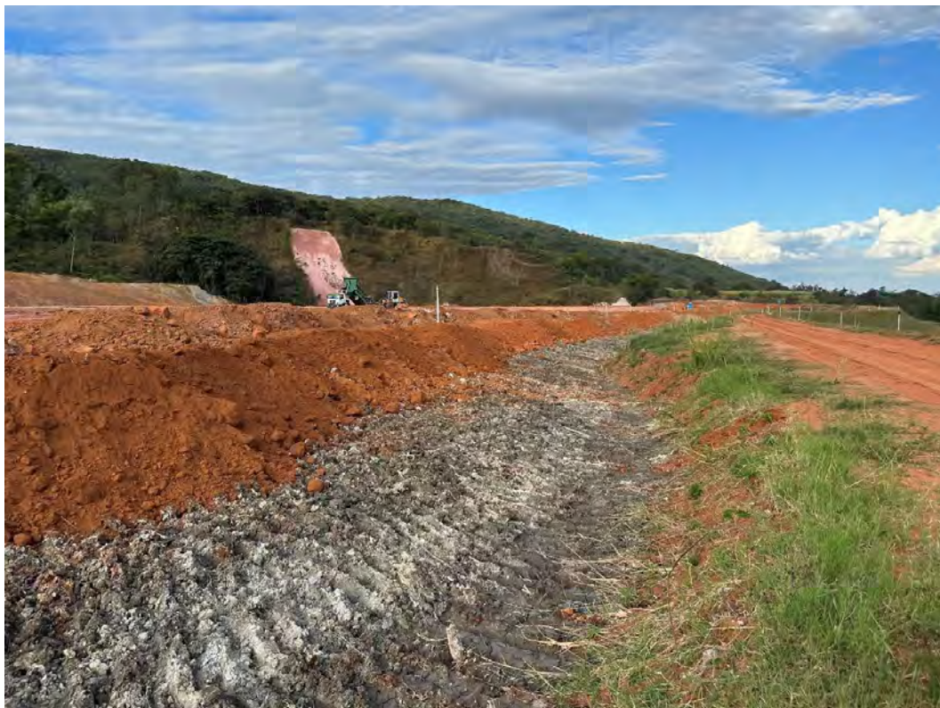
Foto 3 – Reservatório – Detalhe para o avanço do aterro de fechamento do reservatório.
